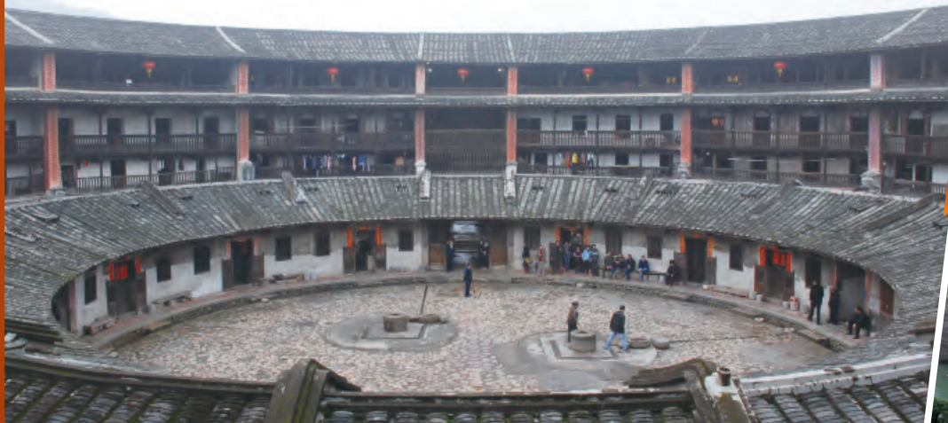
▲中國古建築奇觀—土樓。 ▶武夷山九曲溪中的「六曲」。
