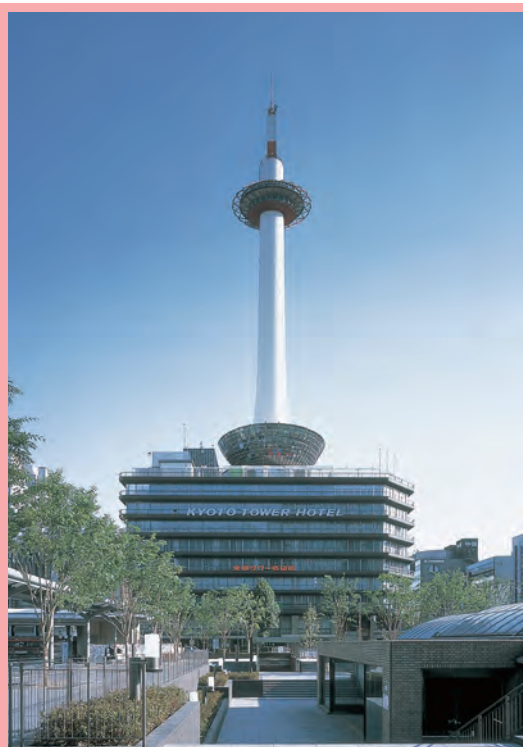
▲京都塔就位在京都車站的正前方。
