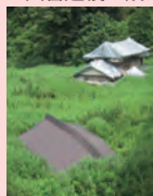
▲中越震災走山後的滅頂房屋遺址與紀念中心。
