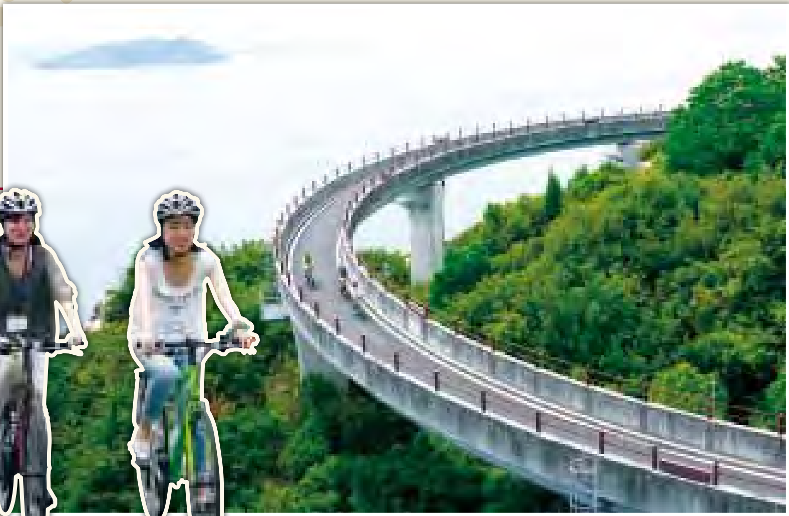
◀▲騎在跨海大橋上，兩邊就是瀨戶內海的星羅島嶼風情。
