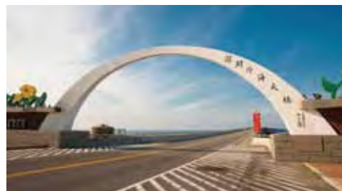
▲澎湖跨海大橋。
