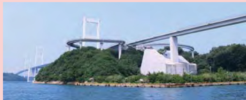
▲世界首座三連式吊橋—來島海峽大橋。
