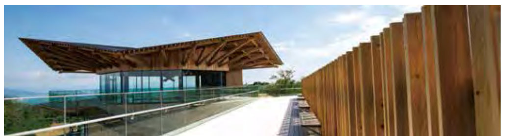
▲3層樓高的頂級展望設施「日本平夢Terrace」。
