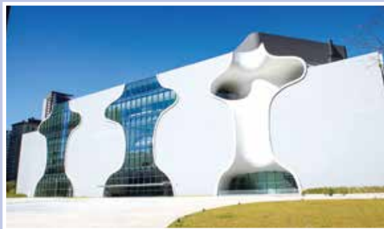
▲台中歌劇院造型前衛，以「美聲涵洞」概念，採用曲牆、孔洞與管狀等別具一格的設計，整棟建築完全沒有樑柱支撐，也無一處為90度牆面，顛覆了一般建築物的概念。
