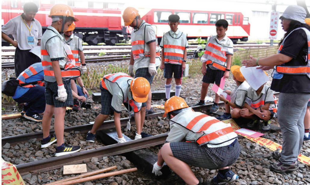
▲夏令營活動非常豐富（圖為協力進行枕木更換）。
