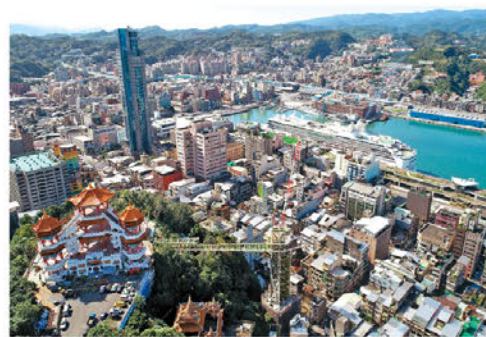
▲基地位於斜坡的豎梯工程，施作難度複雜高，工地現場各式機具與工人忙碌進出，期能如質如期完工。
