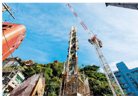
▲「山海城串聯再造計畫」於義二路及信四路交叉口，興建立體豎道與高架人行棧橋，連結主普壇廣場，並於信二路防空洞內，興建無障礙電梯連結上方扇型廣場，打造基隆新地標。
