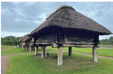
▲境內可欣賞被復原的掘立柱建築，以及當初出土的建築遺跡等。
