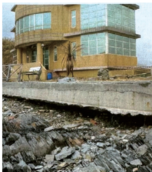
▲飯店在修建期間屢遭颱風阻斷工程進行。
