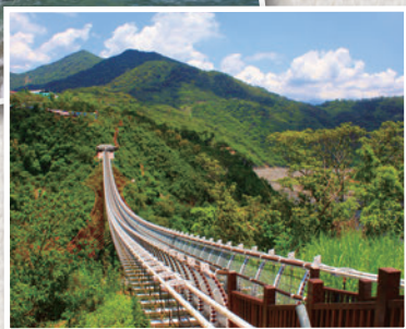
▲屏東三地門山川琉璃吊橋
