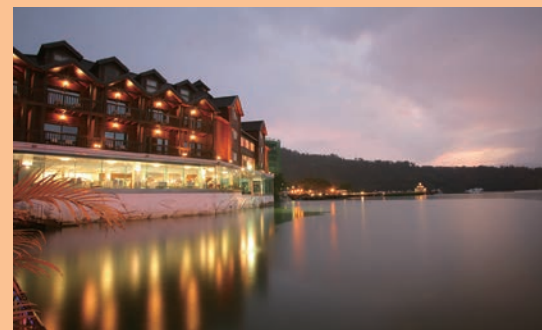
▲力麗麗山會館日月潭館整棟建築以檜木打造，更擁有「亞洲第1大木屋」之美譽。
