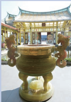
▲▼於2012年開幕的玻璃媽祖廟，以筏式水泥基座結合鋼骨作主結構，運用高科技隔熱安全玻璃作屋面及外牆材質，加上木雕、石雕精品，融合彩繪窯燒、熱塑、堆疊玻璃執行內裝修飾，可說是多元文化及藝術創作匯聚。
