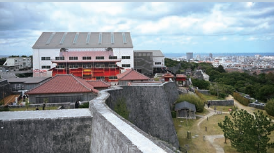
▲沖繩首里城正殿預計在2026年秋季完工。
