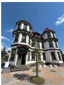
▲舊弘前市立圖書館為文藝復興樣式的木造建築。
