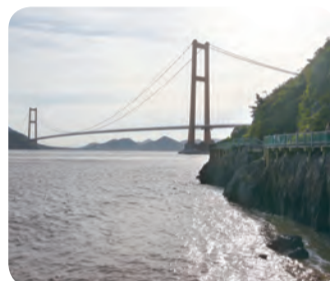
▲舟山跨海大橋風景旅遊區可見識到人類建築藝術的結晶。
