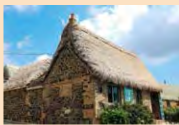
▲以海草覆蓋屋頂有冬暖夏涼之效，超過七十道工序才能完成的海草房百年不腐。
