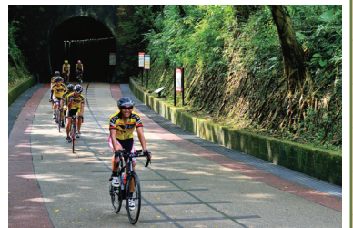
福隆 - 舊草嶺隧道
