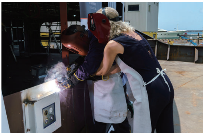
▲Seabourn Venture的傳統硬幣儀式於7/13舉行，Versloot-West將一枚紀念幣焊接到船結構上。
