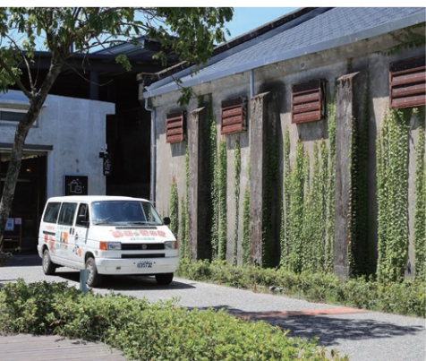
站旁的良食農創園區，是全新推出的農業創生園區。
