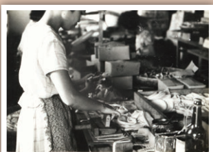
◀早期手工印刷氣球，圖案都是人工用沾著印刷油墨的印章蓋在氣球上。
