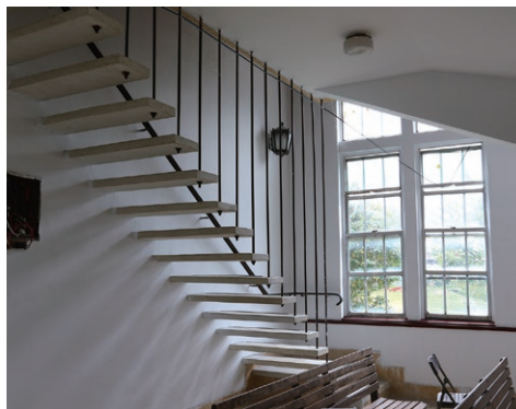
▲通往頂樓鐘塔的「無扶手」樓梯，採穿透性設計，僅用屋頂垂下的鋼條、連結平面鋼板鑲入牆面，美不勝收。
