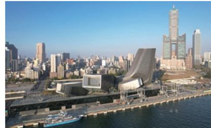
▲高雄港旅運中心是地下2層、地上15層鋼骨構造加上曲面金屬帷幕3D曲面外牆的建物，為郵輪旅客及海內外遊客來到高雄港臨水岸觀景的最佳新景點。
