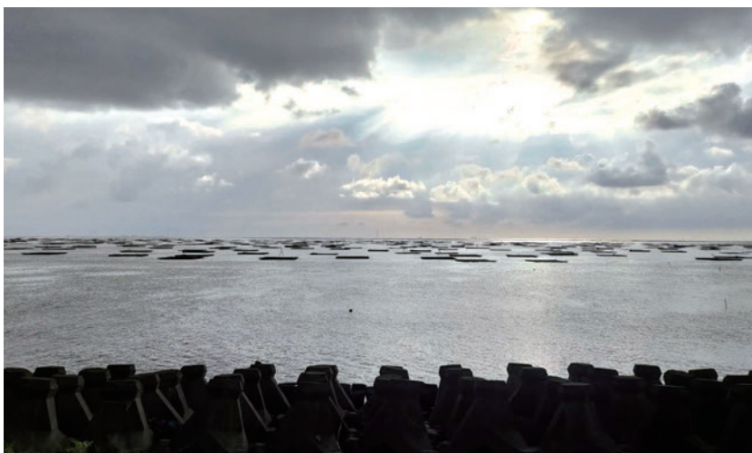
▲緊臨公辦露營區的防汛道路與海堤景觀。
