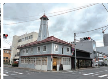
▲紺屋町番屋原為消防設施，在2022年經過防震改修後1樓作為咖啡廳營運。
