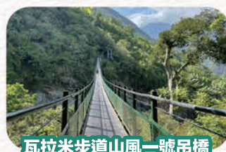
瓦拉米步道山風一號吊橋
